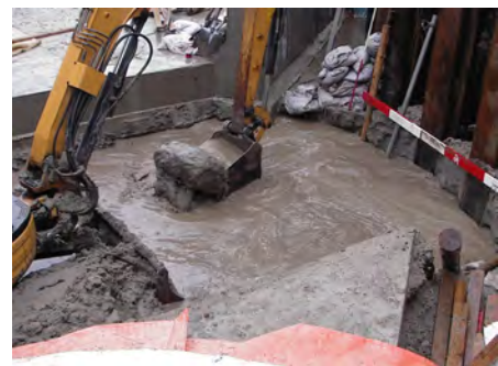
写真-9 : 液状化した地盤の状況
