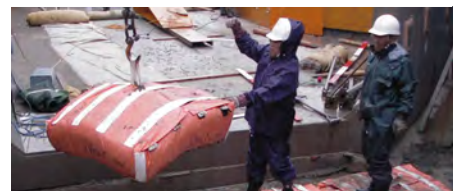
写真-10 : D・Box 敷設の状況
