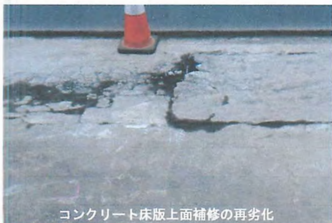
コンクリート床版の土砂化
