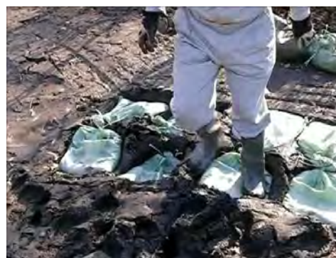
写真-3：軟弱地盤での土のうの様子
