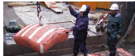
写真-10 : D・Box 敷設の状況
