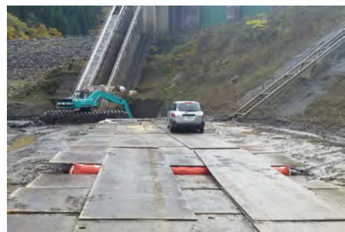
写真-7：①～④の作業状況
