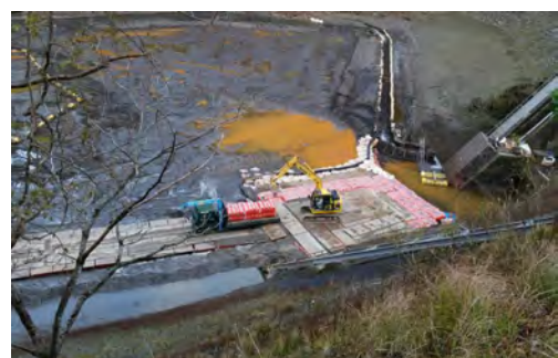
写真-8：仮設道路と作業ヤードの状況
