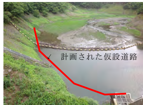
写真-6：現場状況
