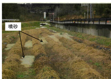
写真-1 国道 359 号被災状況
