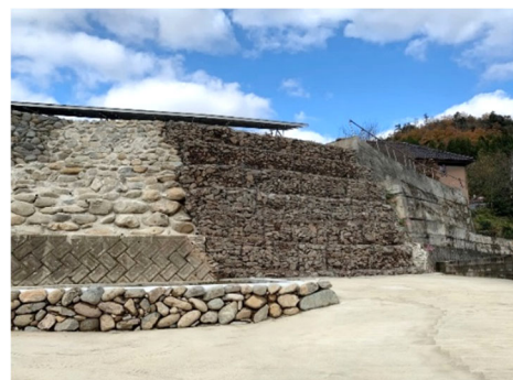
写真-3 TM-Y 施工完了後
