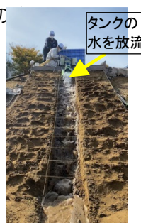
破碎貝殻層（厚さ10cm）の施工状況と越流実験の状況例
