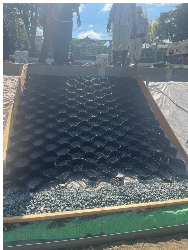
ジオセル+貝殻(タイプB)の施工状況
