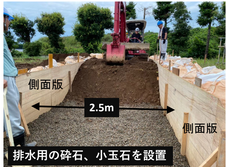
堤体の構築状況
