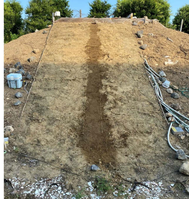
(b)修復後の法面状況
