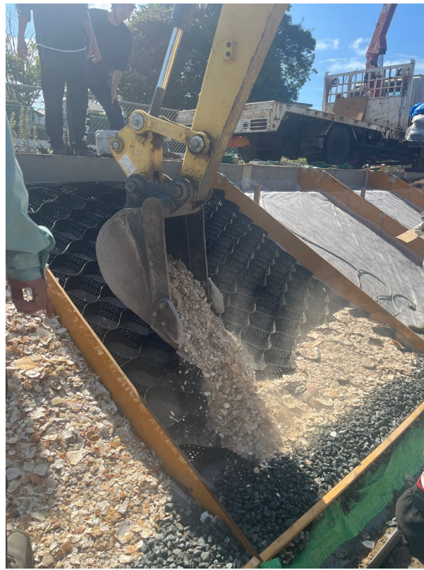
ジオセル+貝殻(タイプB)の施工状況
