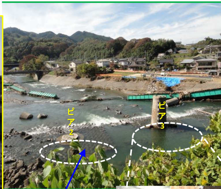
被災後のピア上流側設置ブロックは残っている
