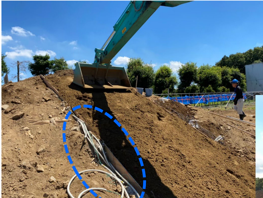
埋設したセンサーの ケーブル保護シース類
