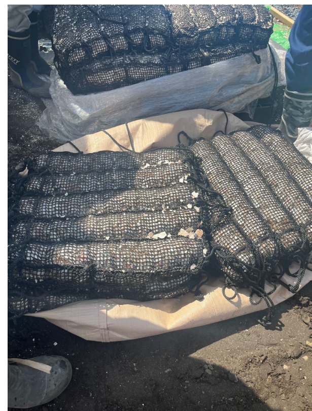
ジオネット+貝殻（タイプC）の施工状況
