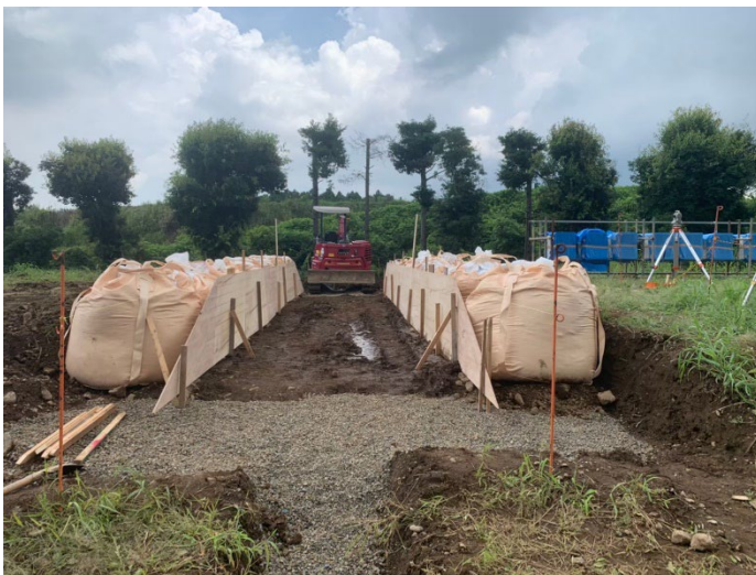
両サイドに堤体形状の コンパネ設置状況
