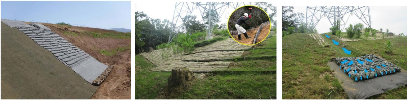
(a) ストーンバッグ (b) 鋼製しがら (c) 雨水誘導マット
