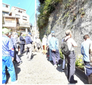
周囲の擁壁・崖・野島層を巡検
