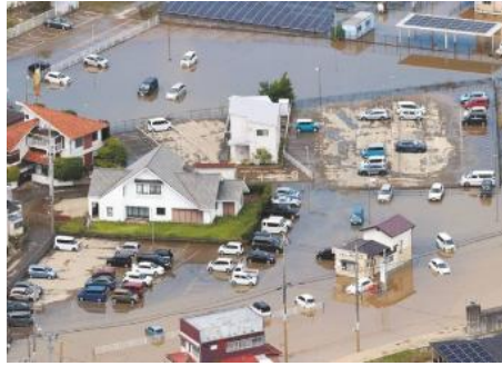
写真 1 大網白里市における氾濫状況 4)
