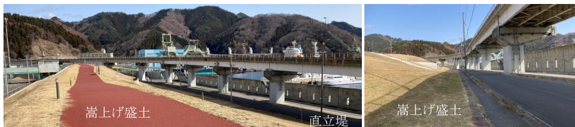
写真5-2 防潮堤の背後に設置されている盛土：釜石市港町
