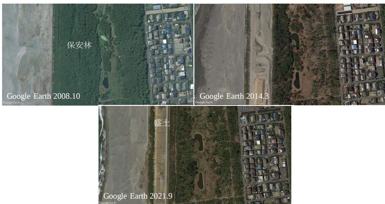
写真75 一条堤の変遷例：左上・整備前、右上・整備中、下・整備後、Google Earthに加筆
