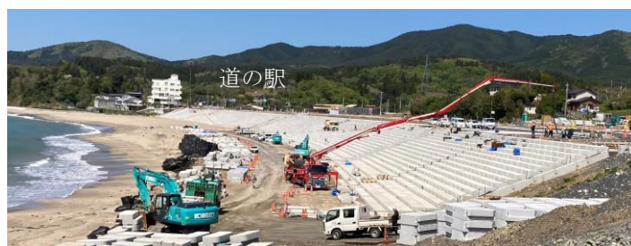
写真21-3 工事中の状況：傾斜堤（奥）とCSG堤（手前）：気仙沼市大谷海岸、2021.5
