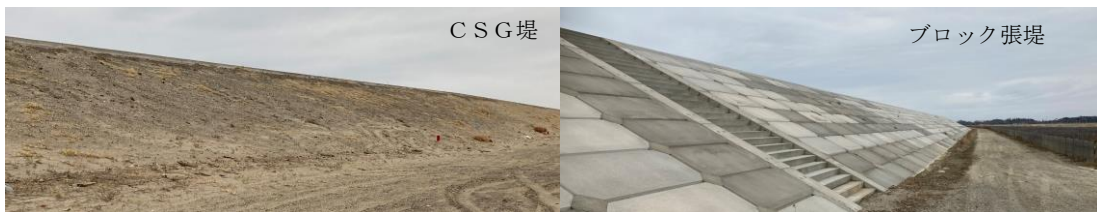
写真23-6 CSG堤とコンクリートブロックによる傾斜堤の比較
