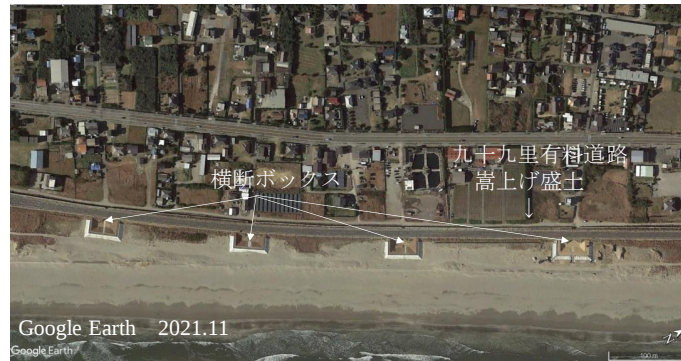
写真74 防潮堤の本堤としての道路盛土：千葉県九十九里有料道路、Google Earthに加筆
