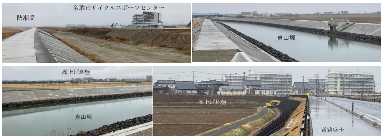
写真45 嵩上げ地盤と道路盛土の一体性：名取市関上、2021.3
