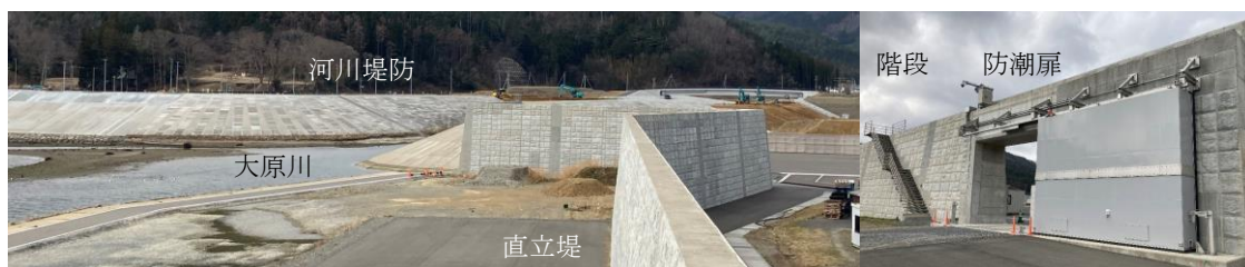
写真7-1 防潮堤と河川堤防の連続性：雄勝漁港・大原川河口～雄勝漁港、2021.3
