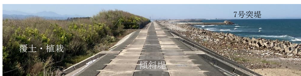
写真17-3 復興後の防潮堤：2021.3 *写真17-2右上とほぼ同じ位置
