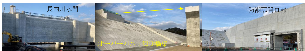
写真2-3 防潮堤に関連する構造：長内川水門、オーバースパス、防潮扉
