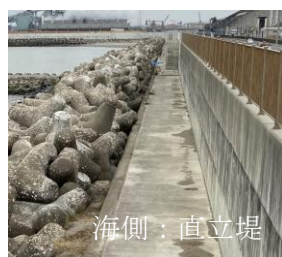
写真9 裏法傾斜構造の防潮堤：石巻市雲雀野町
