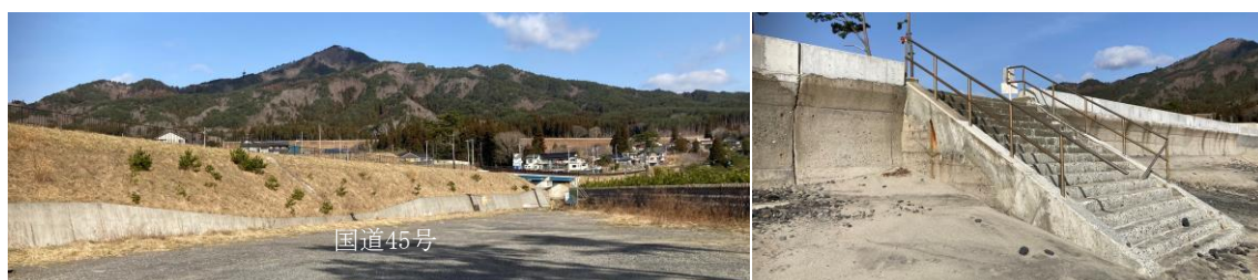
写真24-7 国道45号道路盛土（海側）と防潮堤：2021.3
