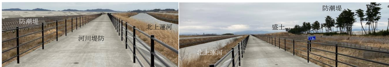
写真30-3 防潮堤、保安林、盛土、北上運河による多重防御：東松島市大曲浜：2021.3
