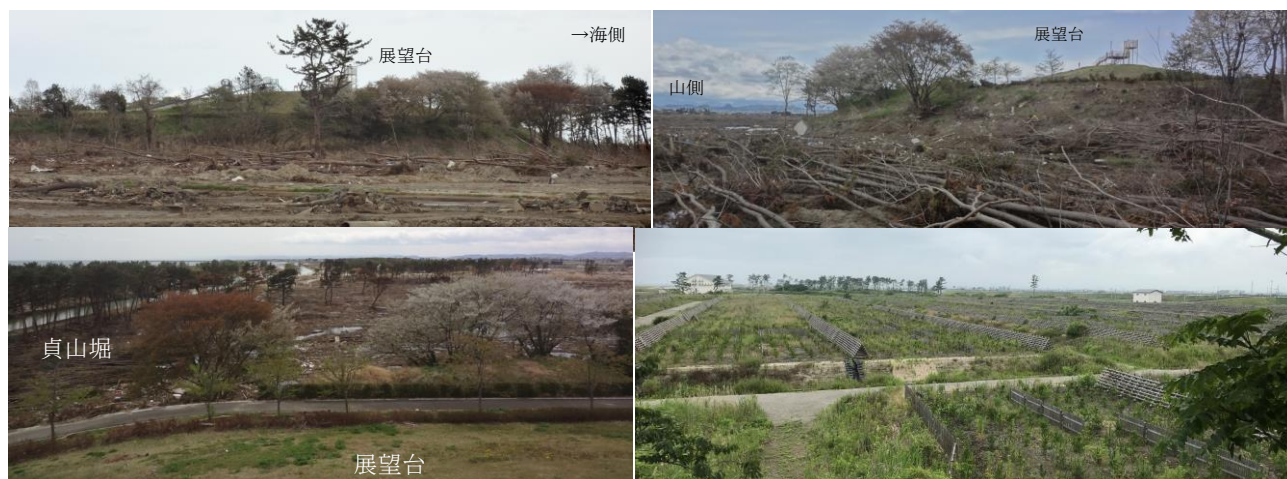
写真46-2 冒険広場の盛土などの被害：左上・左下・右上2011.5、右下2020.7
