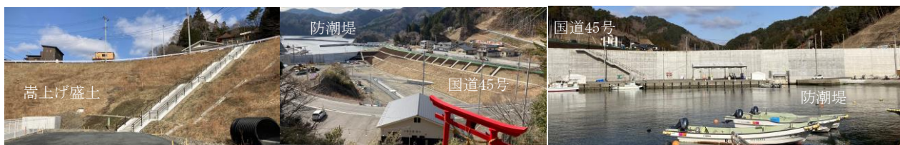
写真42-3 嵩上げ盛土、防潮堤の状況：2021.3
