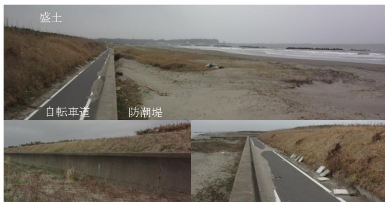
写真71-1 防潮堤に対する二線堤としての盛土：千葉県旭海岸、2011.5
