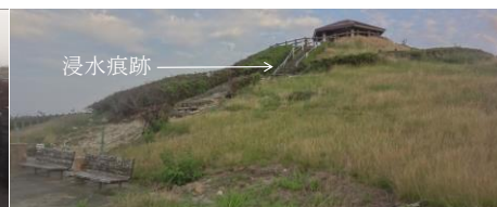
写真47-2 第4号丘として復元された高台盛土の津波による被災状況：2011.7
