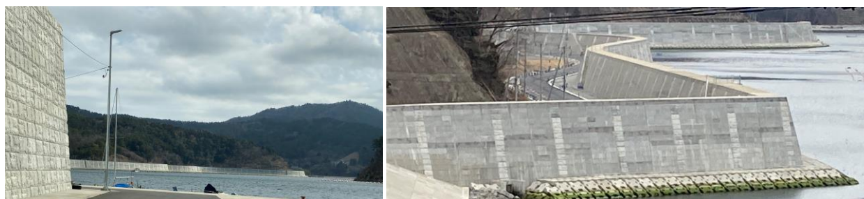
写真7-2 雄勝漁港からの遠望の防潮堤と近景：2021.3
