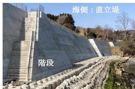
写真8 海側直立堤＋裏法傾斜構造の防潮堤：気仙沼市石浜漁港
