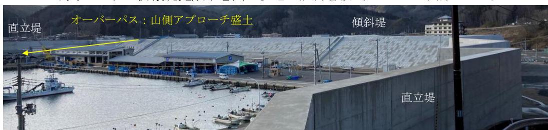
写真2-2 田老漁港付近の防潮堤とオーバーパスの位置
