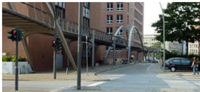
写真51-3 洪水対策の避難橋の例：ハンブルク市ハーフェンシティ地区 27)
