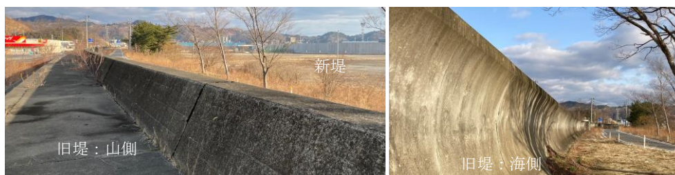
写真4-2 旧防潮堤：宮古市宮古港
