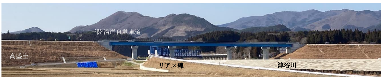
写真 26-2 津谷川を渡河する三陸沿岸自動車道の橋梁の取り付け盛土：2021.3
