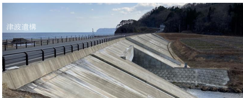
写真73 防潮堤の本堤としての道路盛土：明戸海岸、2021.3
