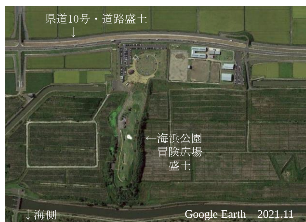
写真63 冒険広場：仙台市若林区
