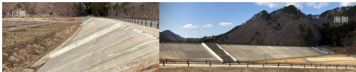
写真35-5 道路盛土の山側（左）、海側（右）：明戸海岸、2021.3
