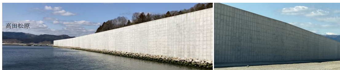
写真25-5 脇之沢漁港の直立堤：左・奥に高田松原を望む、右・陸側、2021.3
