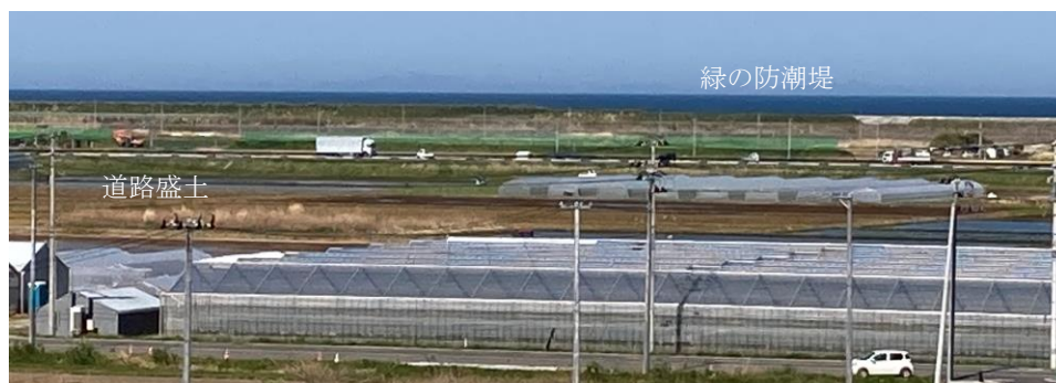
写真34-2 (主) 相馬亘理線の道路盛土、緑の防潮堤：2021.5
