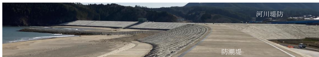
写真12-1 防潮堤と河川堤防の連続：気仙沼市中島海岸
