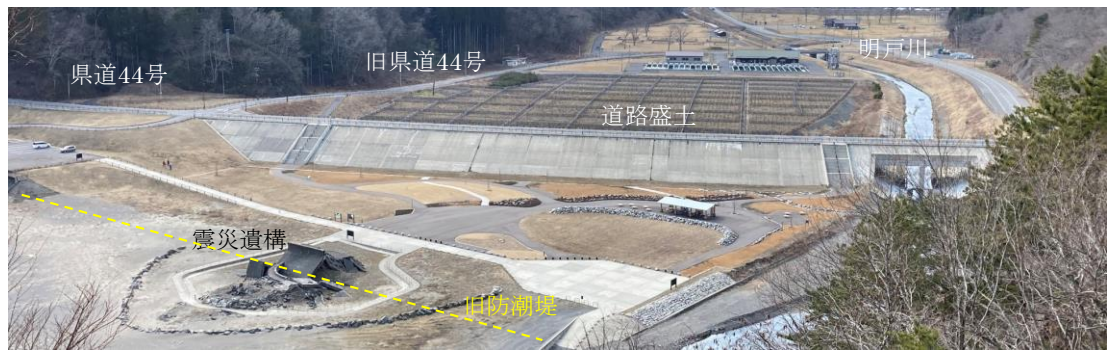
写真35-3 海側からの復興の状況：明戸海岸、2021.3
