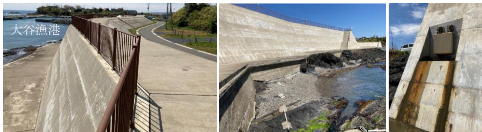
写真11-1 直立堤と傾斜堤の複合構造：気仙沼市・大谷漁港付近
