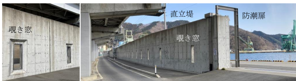
写真5-1 防潮堤と防潮扉：釜石市港町
