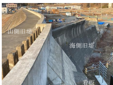
写真2-5 左・旧堤防、右・新堤防の構造諸元：B-1・傾斜堤、B-2・直立堤：現地の看板による
