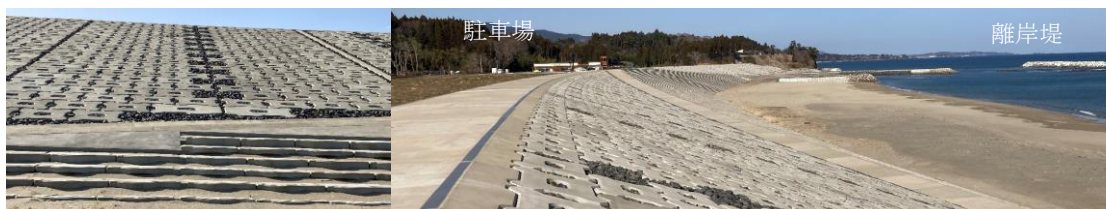
写真12-2 防潮堤の海側：気仙沼市中島海岸
