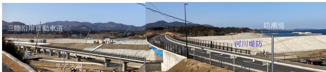
写真 26-3 中島海岸の防潮堤、河川堤防、三陸沿岸自動車道の全景：2021.3
