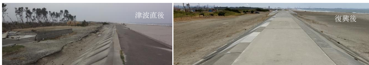
写真15-1 津波直後と復興後の防潮堤：仙台市荒浜、左：2011.5、右：2021.3
