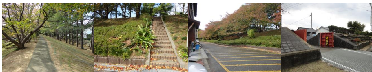
⑤ 土堤・天端
