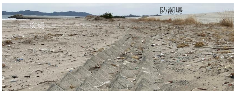
写真30-2 防潮堤が整備された大曲浜：2021.3
