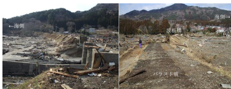
写真24-4 JR山田線の盛土、橋梁の被害状況：浪板地区代表・台野宏氏の提供に加筆
