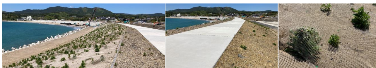
写真22-2 CSG堤の表法の覆土・植栽、裏法の覆土：2021.5
