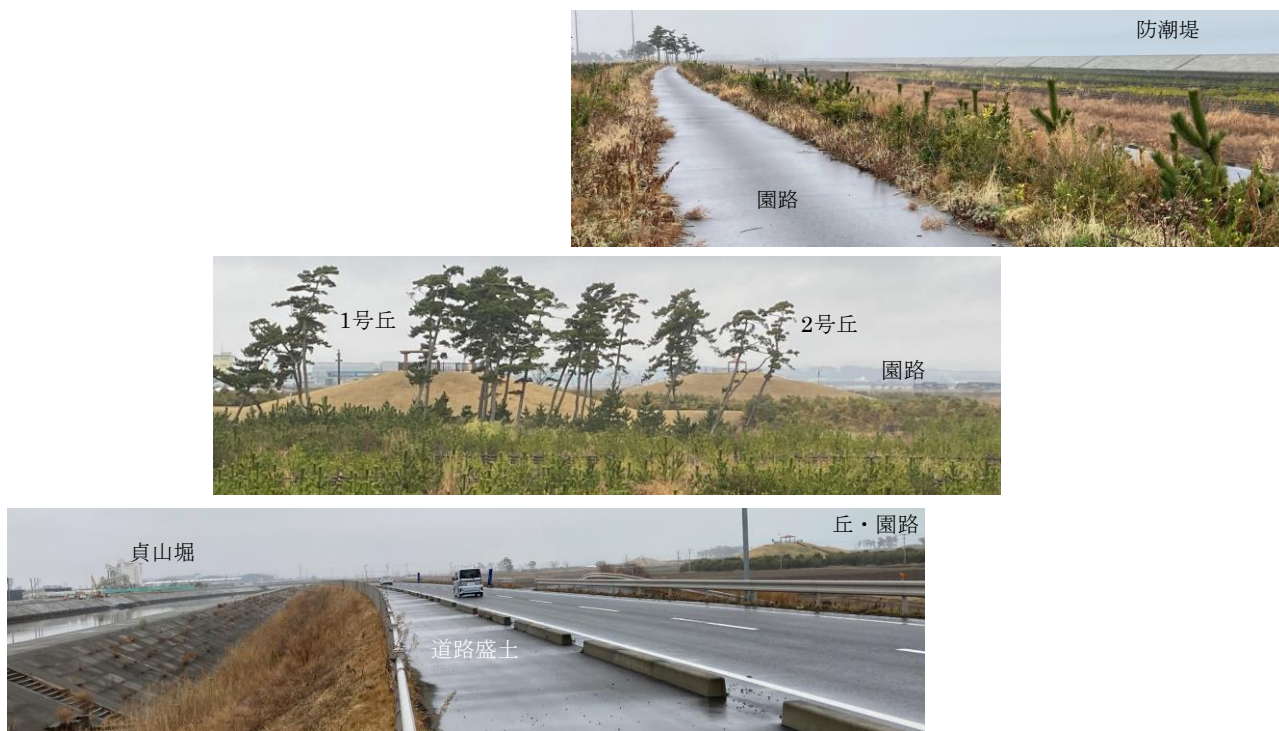
写真32-2 千年希望の丘地区の多重防御：上・防潮堤～園路、中・丘、下・道路盛り土・貞山堀
