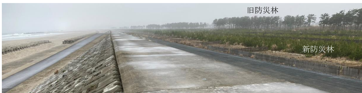
写真16-2 コンクリートブロックの三面張構造の傾斜堤による復興状況：亶理町吉田浜、2021.3
