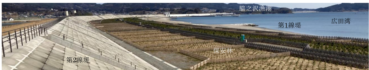
写真25-3 復旧された防潮堤と松原：高田松原、2021.3
