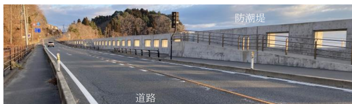
写真6-2 防潮堤の背面の道路：宮古市藤の川
