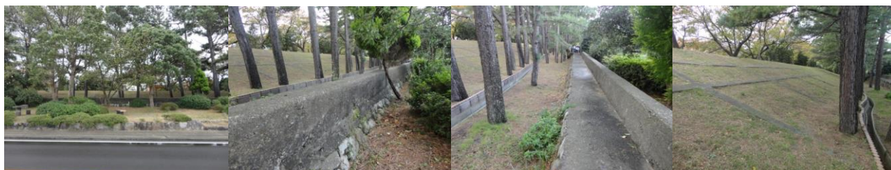
① 海側取り付け部
