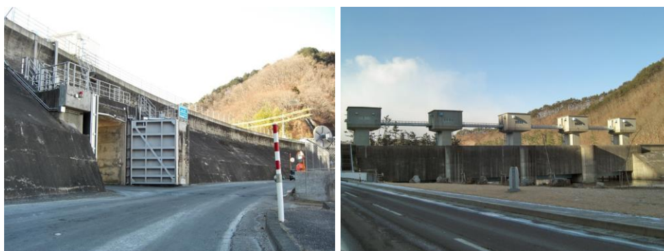
写真36-1 太田名部防潮堤（右）と普代水門（左） 57)
