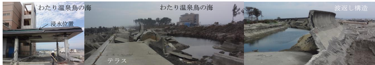
写真20-2 わたり温泉鳥の海、津波による決壊した防潮堤：写真中・右／テラスの有無、2011.7
