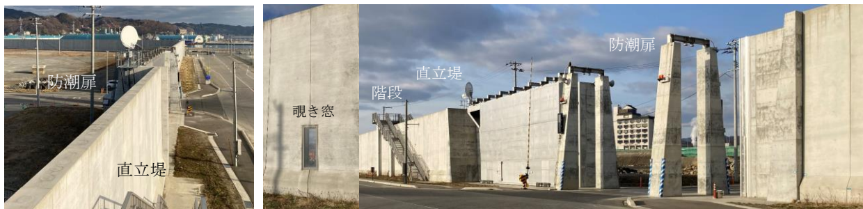
写真4-1 新防潮堤：宮古市宮古港
