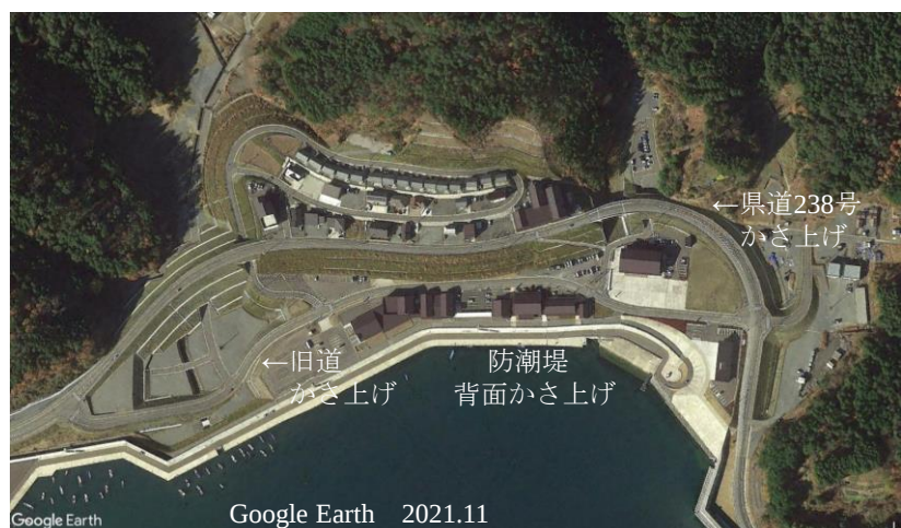
写真66 下雄勝地区：石巻市
