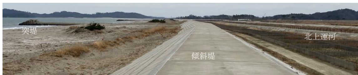
写真14-1 新設された防潮堤から幻の野蒜港方向を望む：東松島市大曲浜
