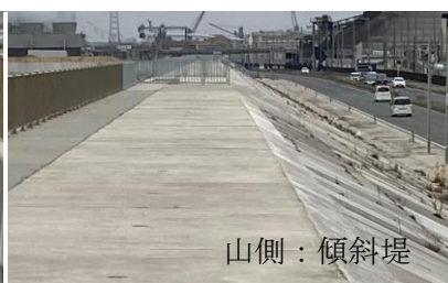
写真9 裏法傾斜構造の防潮堤：石巻市雲雀野町
