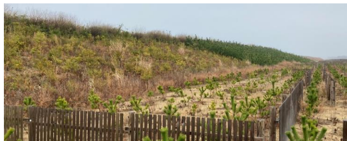
写真19-4 「緑の防潮堤」の裏法：陸側、岩沼市寺島
