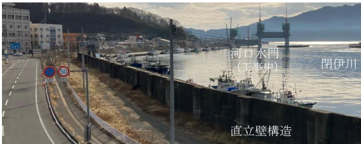
写真1-2 津波の越流に耐えた直立壁構造：宮古市新川町：左・全景、右・陸側、2021.3
