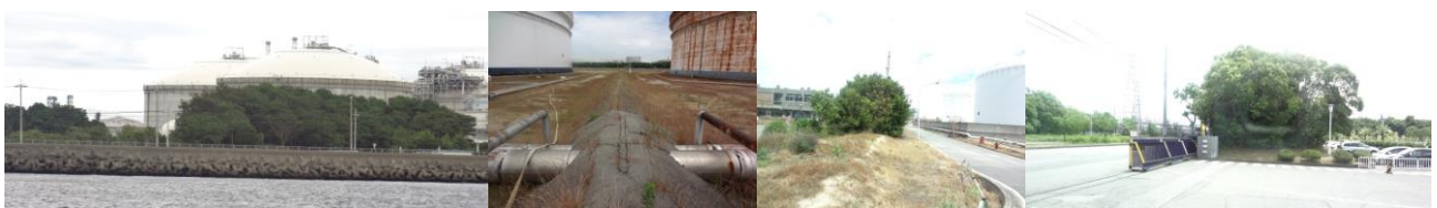
写真67-2 コンビナートの敷地の状況例
