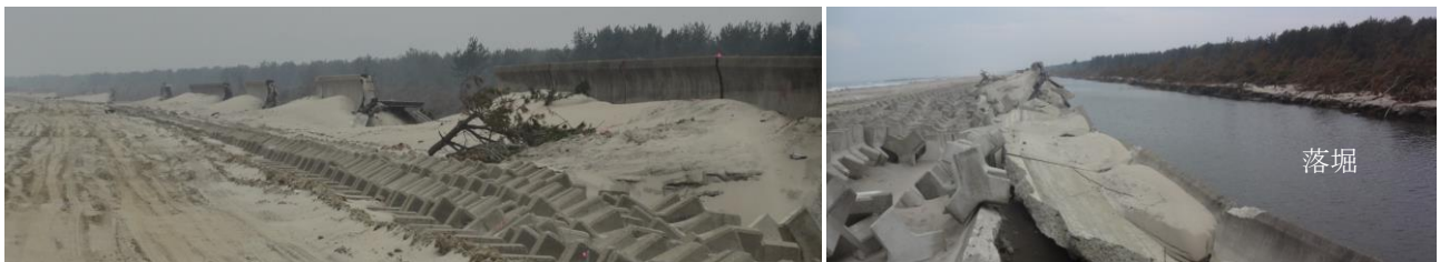
写真16-1 防潮堤の決壊と落堀の形成、防砂林の被害：亶理町吉田浜、2011.7
