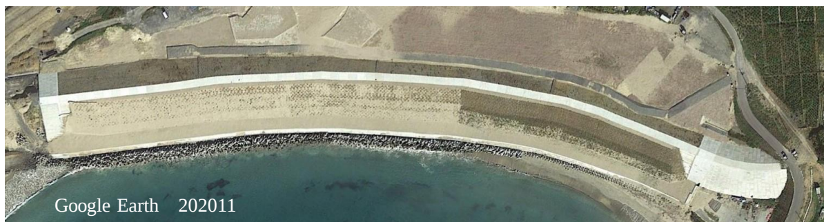
写真22-1 CSG堤の全景：気仙沼市大谷海岸（その2）、Google Earthに加筆
