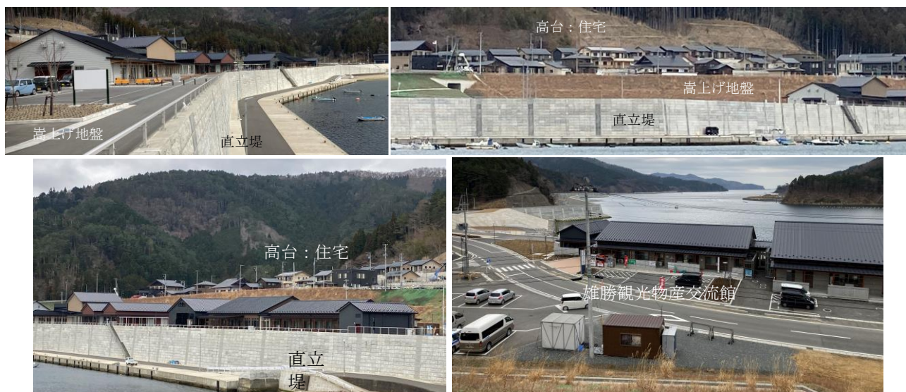
写真41-2 防潮堤、嵩上げ地盤、高台：宮古市雄勝町下雄勝、2021.3
