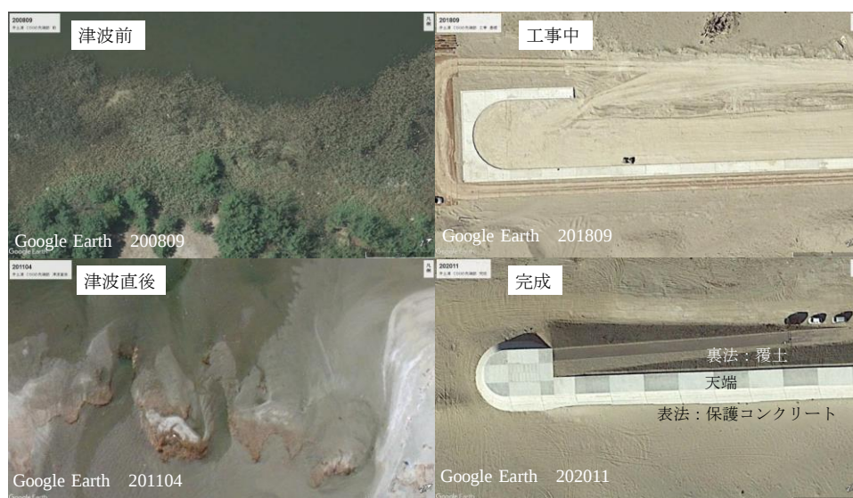
写真23-3 CSG堤の突端部の津波前～工事後の推移：Google Earthに加筆
