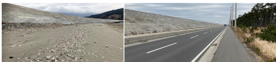
写真13-2 防潮堤の海側（左）と陸側（右）：石巻市長浜
