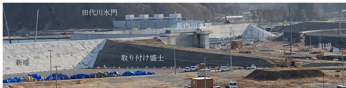
写真2-4 新堤の陸側：オーバースパスの取り付け盛土など、2021.3
