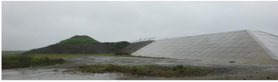
写真20-5 防潮堤の背後における覆土嵩上げ：防潮堤と嵩上げの関係、2016.9
