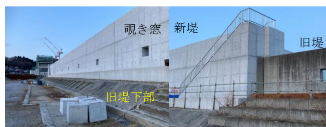
写真3-1 水門と新旧の防潮堤：宮古市閉伊川河口右岸
