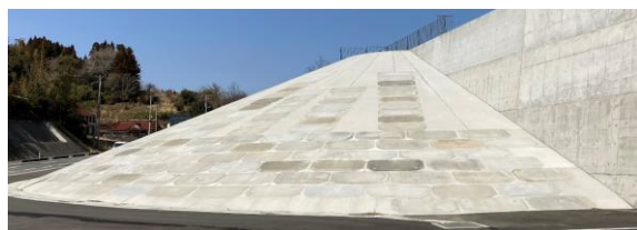
写真8 海側直立堤＋裏法傾斜構造の防潮堤：気仙沼市石浜漁港
