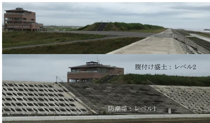
写真72 防潮堤に対する覆堤としての盛土：亘理町鳥の海、2020.7
