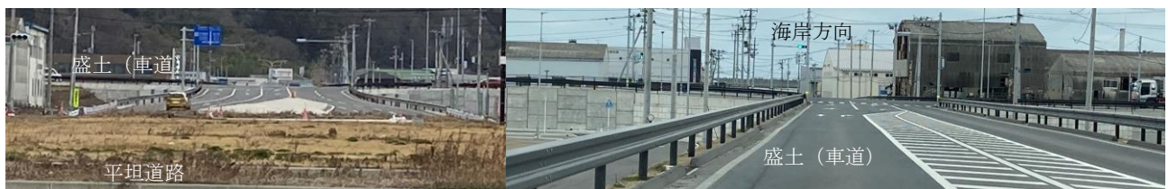
写真29-2 防潮堤～保安林～盛土（遊歩道）～盛土（車道）：2021.3
