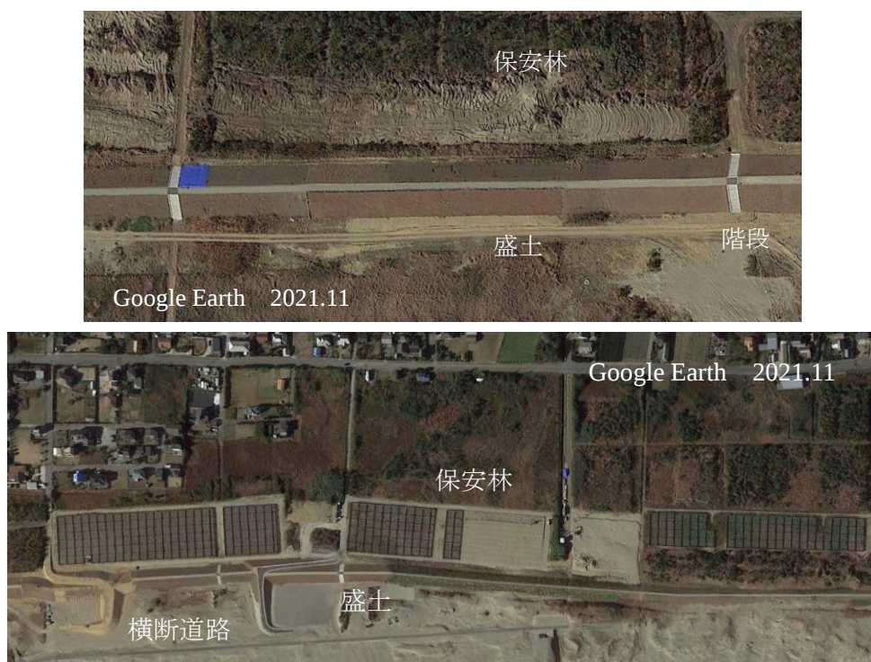
写真37-3 保安林の砂丘による津波対策：上・施工直後、下・横断道路など、Google Earthに加筆
