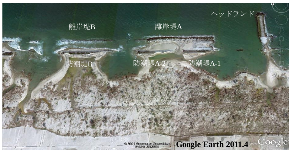
写真17-1 防潮堤の破堤の全景：Google Earthに加筆
