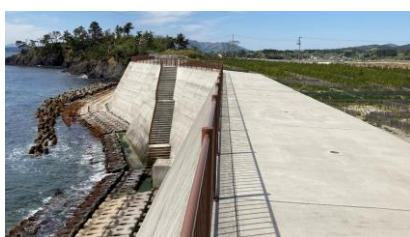
写真10 直立堤と傾斜堤の複合構造：気仙沼市・大谷沼尻海岸
