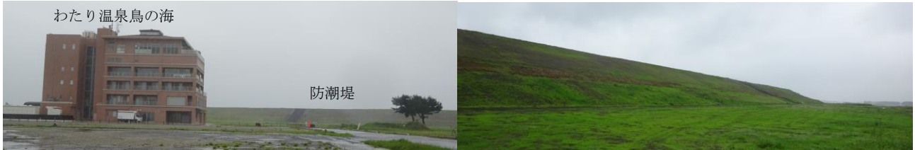
写真20-6 景観に馴染む嵩上げされた防潮堤：陸側の風景、2016.9
