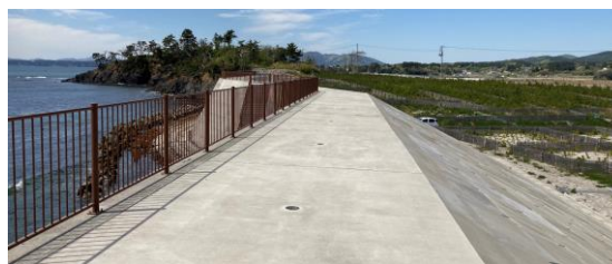
写真10 直立堤と傾斜堤の複合構造：気仙沼市・大谷沼尻海岸
