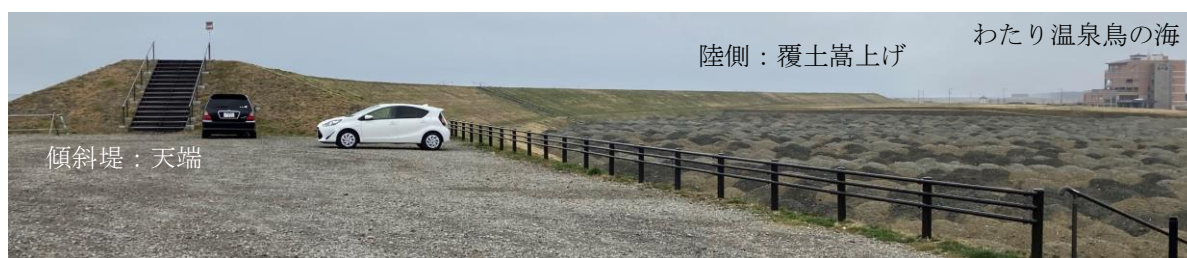
写真20-3 覆土により嵩上げた防潮堤の陸側の様子：2021.3
