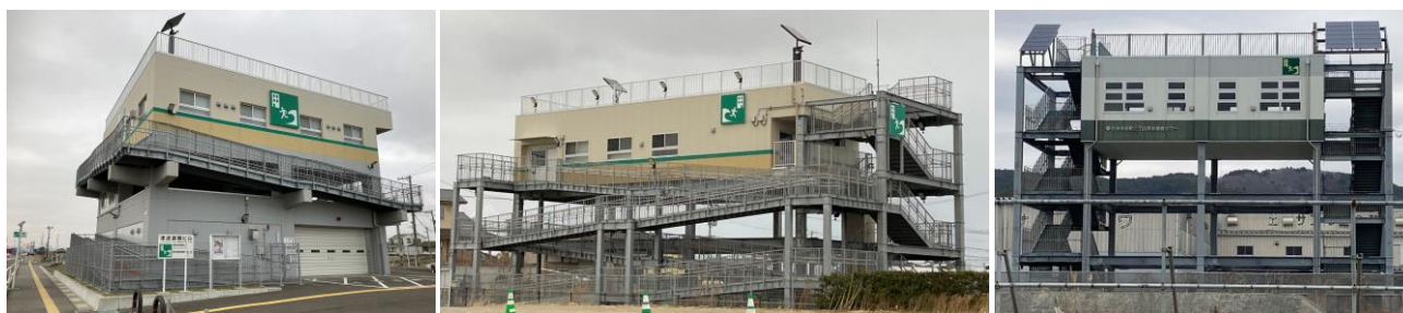
写真51-1 津波避難ビル(左)と津波避難タワー(中・右) : 左・中／仙台市東部地域、右／石巻市魚町
