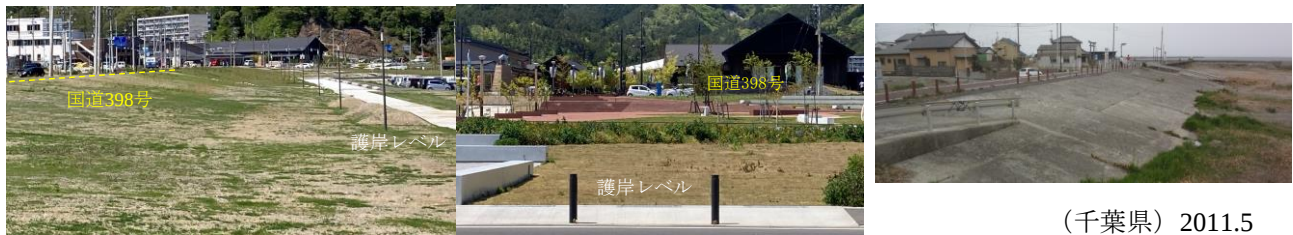
写真 27-2 道路盛土（左・中、2021.5）と緩傾斜堤例との比較
