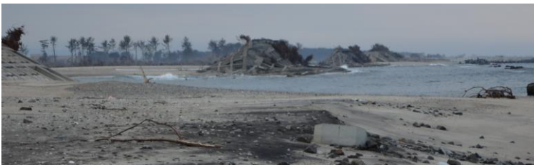
津波で壊滅的に破壊された海岸堤防：山元町
