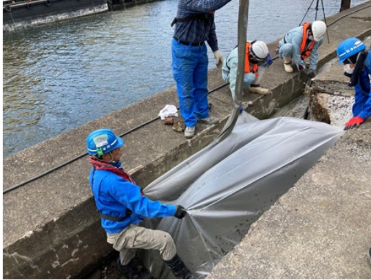
流動化処理土をバッグに注入
