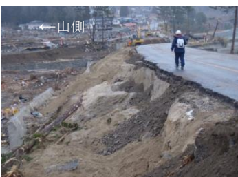
押し波と引き波でも表層侵食に留まった道路盛土：浪板地区
