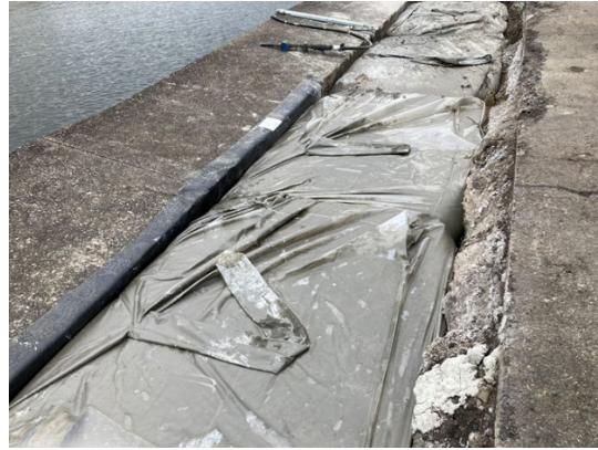
注入充填完了
