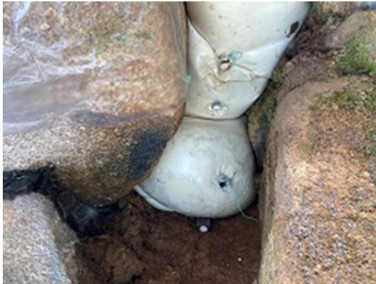
注入充填完了
