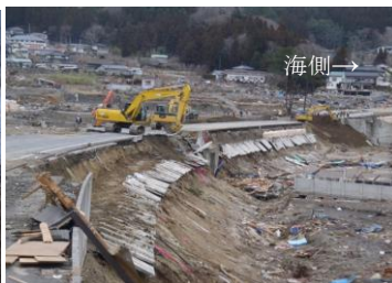
押し波と引き波でも表層侵食に留まった道路盛土：浪板地区
