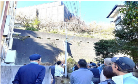
擁壁上・高舟台自治会館及び予定地斜面
