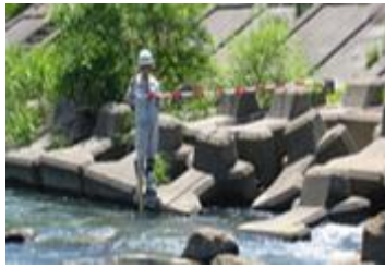
(1)根固めブロックの沈下
