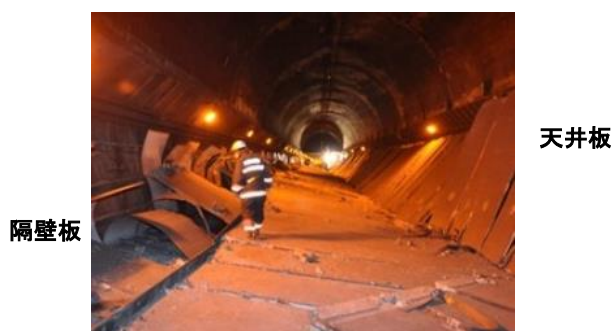
写真1 笹子トンネルの天井板崩落事故（山梨県大月市）（著者加筆） 1)
