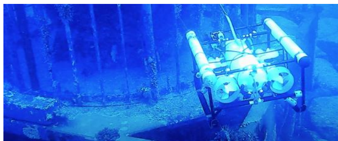
写真 10 水中ドローンによる取水工の点検状況 29)
