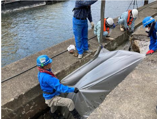
流動化処理土をバッグに注入
