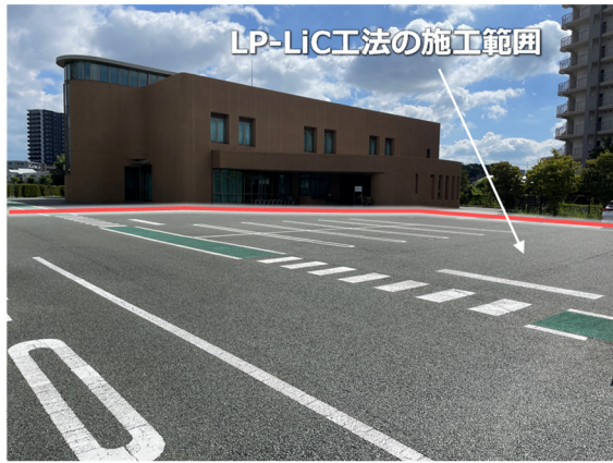
写真-1 丸太打設により液状化対策した駐車場の地震後の様子(飛島建設 HP より引用)
