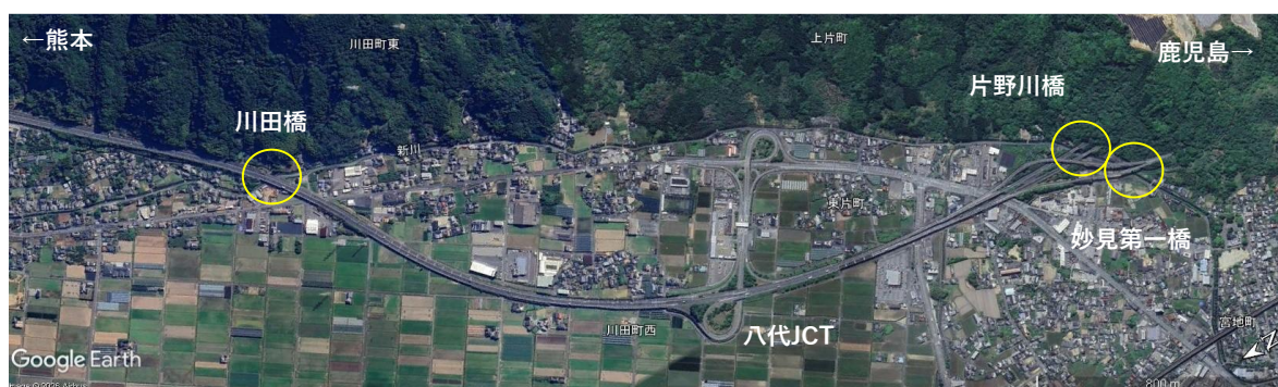
写真 2 九州自動車道の八代 JCT 付近の 3 橋の被害箇所：Google Earth20241123 に加筆
