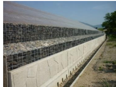
写真-5 壁面材の設置状況
