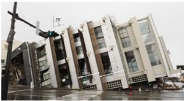
写真-10 七階建てRC造建物の転倒：輪島市 文献40)
