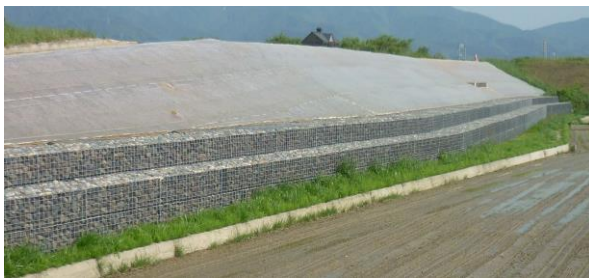
写真-4 ふとんかごの設置状況
