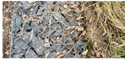
写真-9 かご工の天端の状況 *幅 1.0mのうち、約 0.3mが吸出し防止材の巻込みにより被覆され、約 0.7mが露出しているが、植生の活着が見られる。 2026.3
