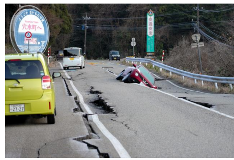
写真-1 繰り返される道路舗装の損傷：2024 年能登半島地震 左：朝日デジタル・土井良典撮影 右：朝日デジタル・小林一茂撮影
