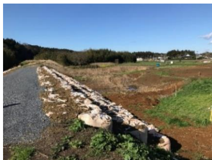
写真-6 応急復旧の状況 202003
