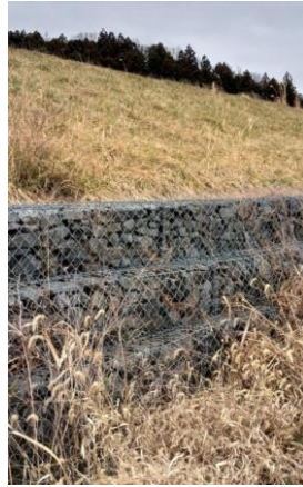
写真-8 かご工の設置状況 2026.3
