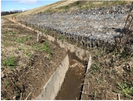
写真-2 「かごマット」の設置状況：2020.3
