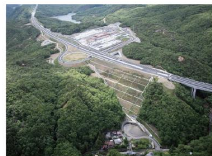
写真-3.17 宝塚北 SA 高盛土完成状況
