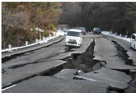
写真-1 繰り返される道路舗装の損傷：2024 年能登半島地震 左：朝日デジタル・土井良典撮影 右：朝日デジタル・小林一茂撮影
