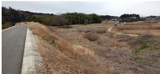
写真-7 本復旧後の現在の状況：202603
