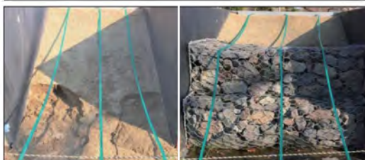
無対策盛土及び対策盛土の概要・状況写真
