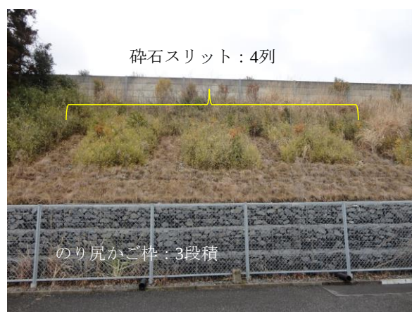
写真-2 既設盛土の後施工の碎石堅排水工：常磐自動車道那珂IC付近
