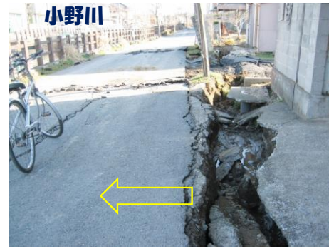
写真-1 液状化による小野川の噴砂・地盤流動の状況：香取市HPを参照、一部加筆
