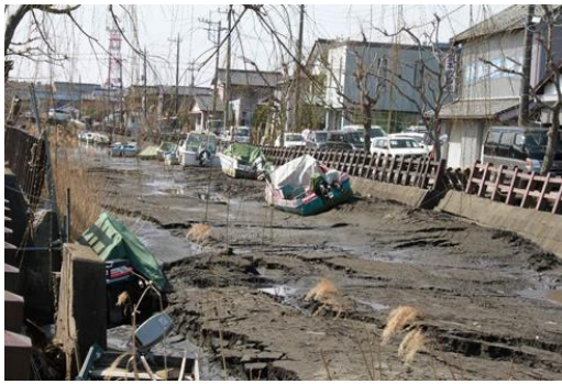
写真-1 液状化による小野川の噴砂・地盤流動の状況：香取市HPを参照、一部加筆
