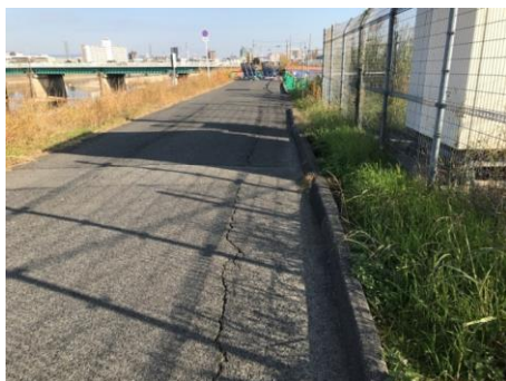
写真 20 天端舗装のアスカーブ例
