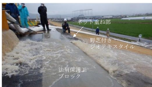
(a) 法肩通水状況：ケース 3
