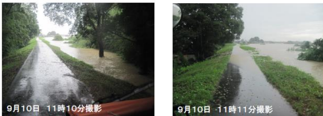
写真4 越流開始（11:11）前後の状況 7)
