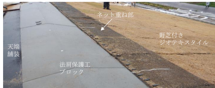
写真 10 川裏側の法肩部の構造：文献 24 に加筆
