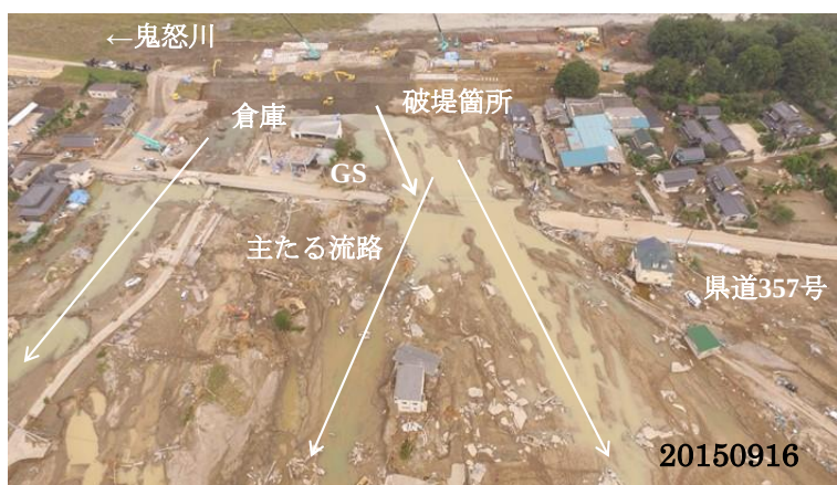
写真 14 堤内地の侵食および落堀の形成：鬼怒川堤防調査委員会／文献 26 の資料に加筆
