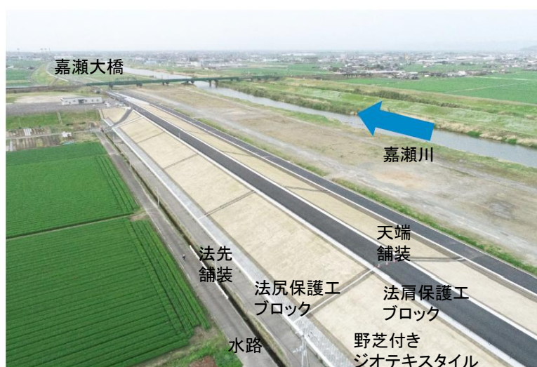
写真12 パイロット施工直後の堤防：文献20に加筆
