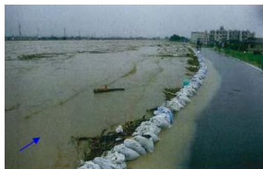
写真 22 水防活動による土のうの設置例 38)
