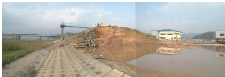
写真 1 円山川の立野地区の破堤状況：左・近景、右・全景 2)
