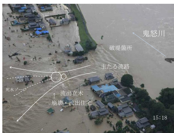
写真 17 浸水状況：国土交通省関東地方整備局提供に加筆
