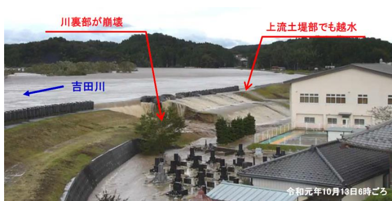
写真6 越流の状況：10月13日6時ごろ 10)
