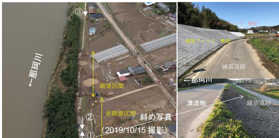
写真 16 破堤区間と非破堤区間の比較：那珂川左岸 40.0k、左・破堤箇所の全景、右上・応急復旧状況（2021.3）、右下・写真左の①による非破堤部の状況 ＊文献 28 に加筆
