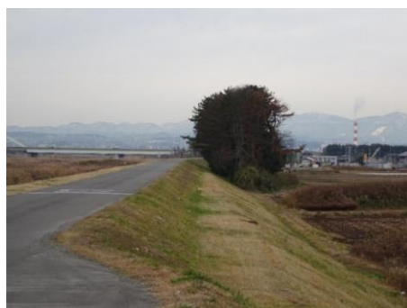
写真 21 堤内地側の法尻の樹林帯
