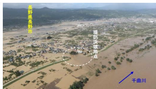
写真 8 越流と破堤の状況 12,13) ：左・6:20 頃、中・10:00 頃、右・13:10 頃
