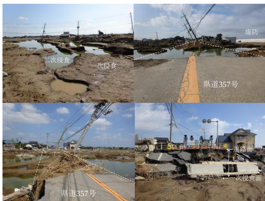
写真 15 堤内地側の地盤侵食 27) ：左上・堤防側から流下方向を臨む、左下／GS 側から県道 357 号の北側、右上／県道 357 号の北側から GS 方向、右下／県道 357 号の北側の決壊断面
