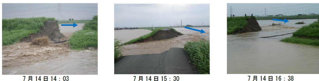
写真 3 破堤（13:20）後の推移 5) ：破堤拡大停止（本文での想定 15:30）
