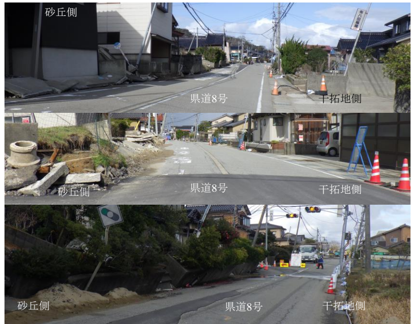
写真-9 県道8号が地盤流動を抑制していると推測される事例
