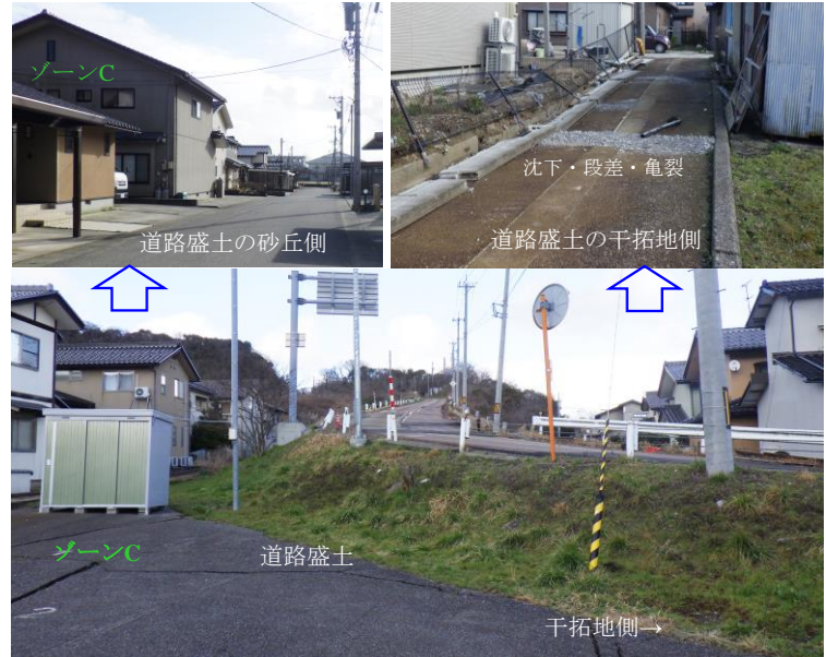
写真-11 道路盛土が地盤流動を抑制していると推測される事例
