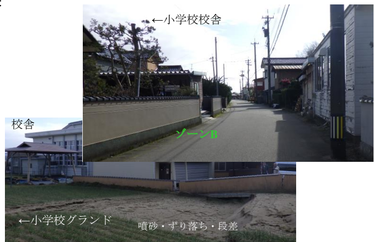
写真-10 校舎が地盤流動を抑制していると推測される事例
