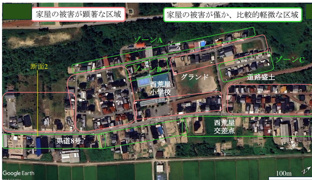
図-9 地盤流動による被害の地域的な差異：西荒屋地区
