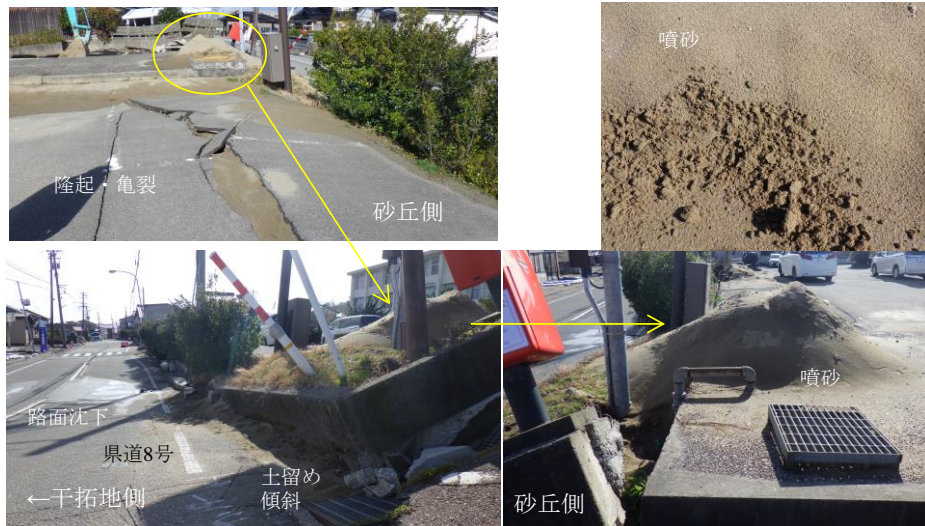
写真-5 道路の沈下と沿道の噴砂・隆起
