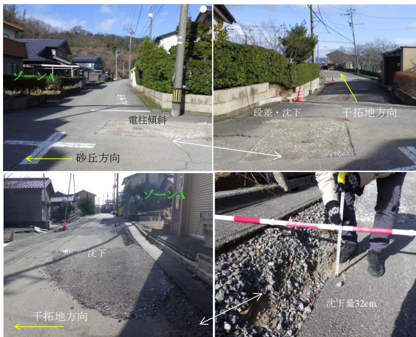
写真-13 砂丘近傍で地盤流動の抑制が推測される事例
