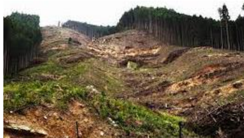
皆伐跡地の作業道からの崩壊状況（球磨川流域）
