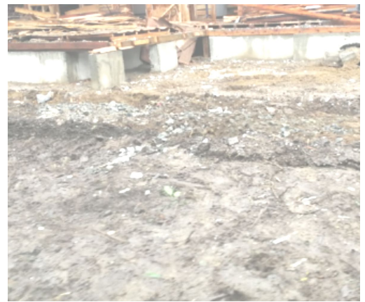
解体中の地盤
