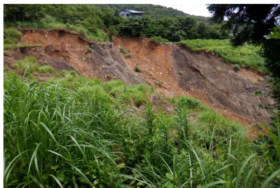
52 盛土の崩壊状況（7月16日撮影）
