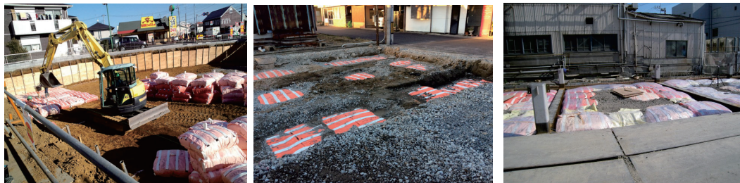
施工例：建築物
