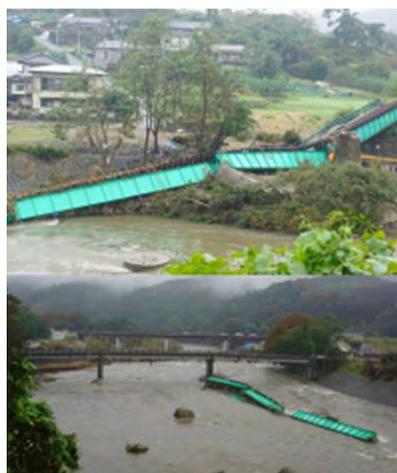
図 1-1-1-13 鉄橋流失箇所の現地の状況
