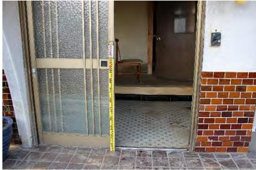
図 1-1-1-4 建物の浸水痕跡 (10月17日小荒井撮影)
