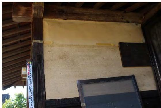
図 1-1-1-2 建物の浸水痕跡(10月17日小荒井撮影)
