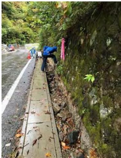
図 1-1-1-16 盛り土の流出による道路脇の陥没
