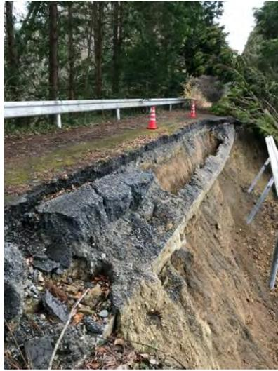
図 1-1-1-18 山道脇の中新統砂岩層の崩落
