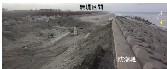
(1) 防潮堤の端部の被害
