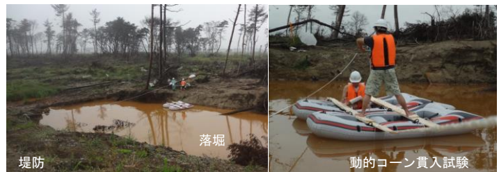
写真-25 ゴムボートによる落堀の調査
