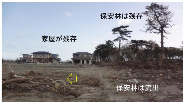
(1) 流出していない保安林の背後で残存した家屋
