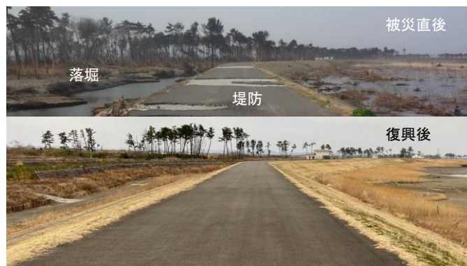
写真-30 被災し、復興された堤防：仙台市若林区井土浦
