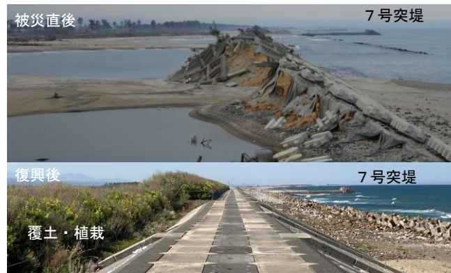
写真-32 復興された緑の防潮堤：山元町高瀬
