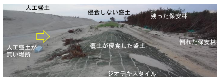
写真-20 覆土が流されても侵食を抑制したジオテキスタイル
