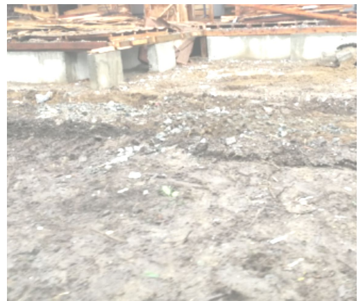
解体中の地盤
