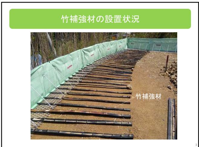
水平補強材は、土の中に敷設して盛土体・地盤を補強・強化し、盛土体の安定性・耐久性を高める目的で使う。
