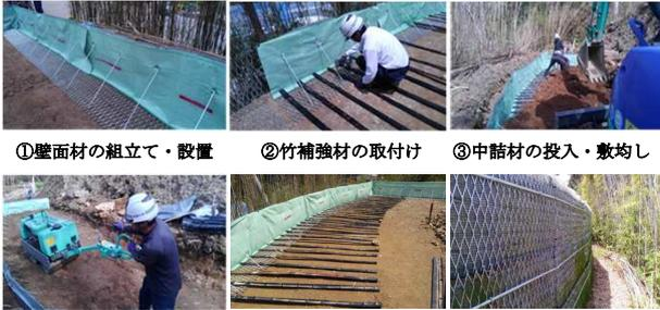
①壁面材の組立て・設置 ②竹補強材の取付け ③中詰材の投入・敷均し
